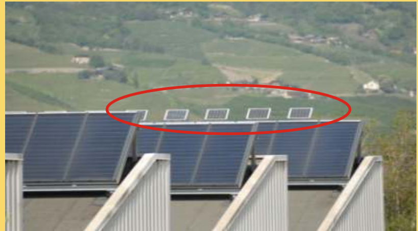
Impianto solare con alimentazione autonoma per le pompe di ricirolo
