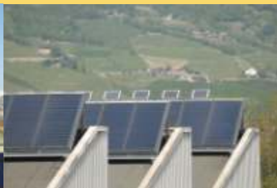
Impianto solare termico 240 m 2 con monitoraggio
