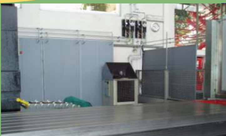
Panelli radianti per riscaldare e raffreddare, 385 m 2
