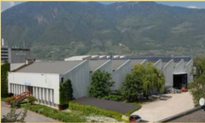
Stabilimento di 2.250 m 2 con climatizzazione ad energia alternativa
