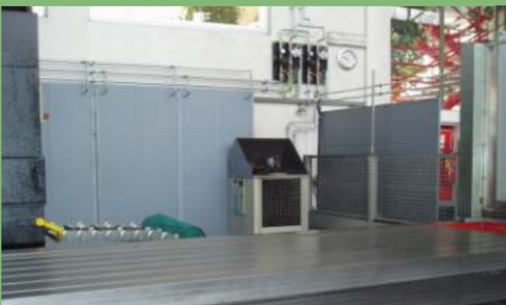
Paneele zum Heizen und Kühlen 385 m 2
